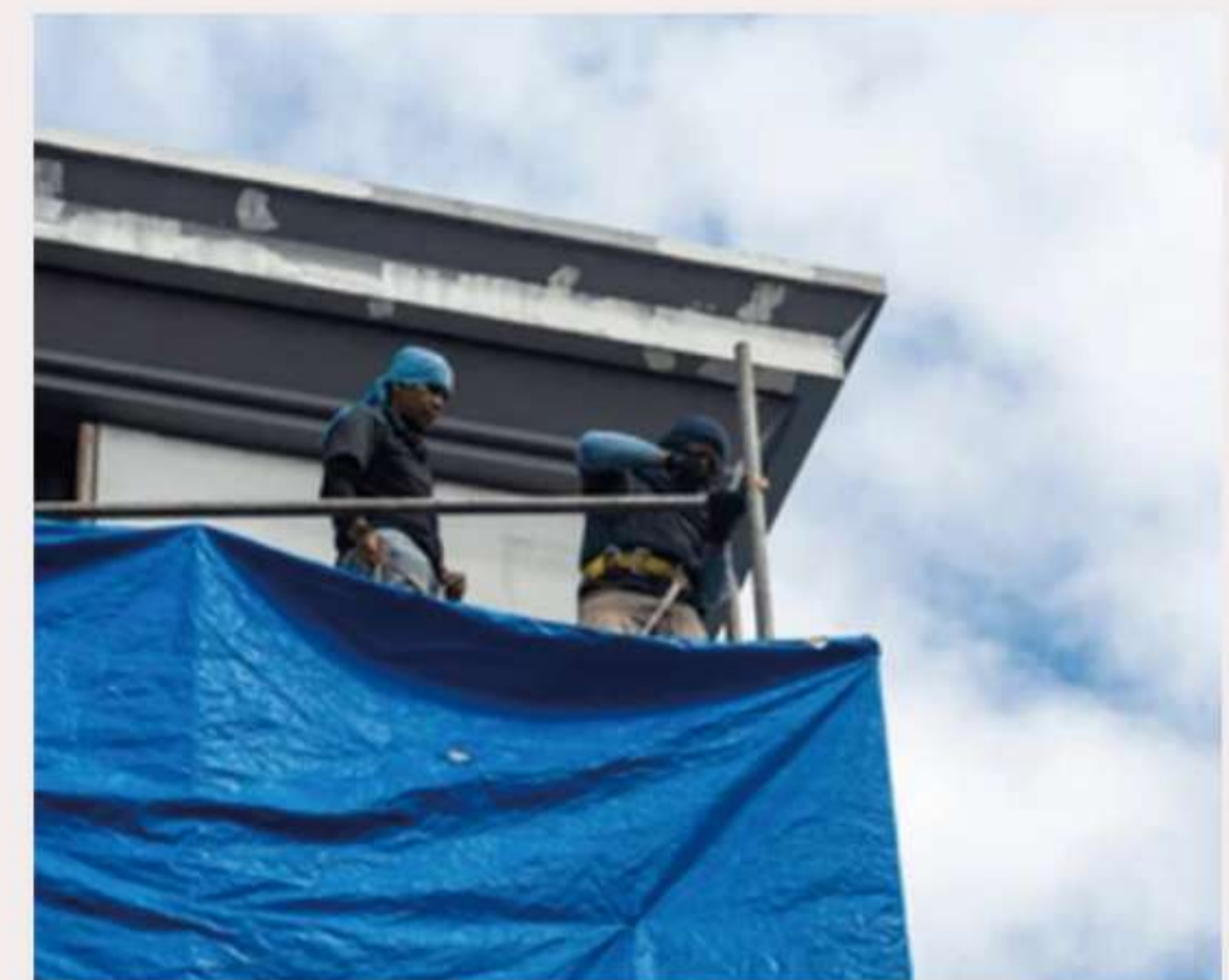
作業現場のブルーシート、 トラックシートの仮押さえに
