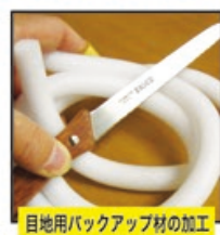
目地用バックアップ材の加工
