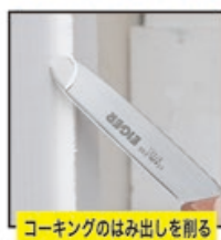
コーキングのはみ出しを削る
