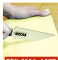
断熱材・グラスウールの加工
